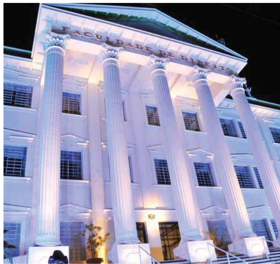
Prédio sede da FDSM.
